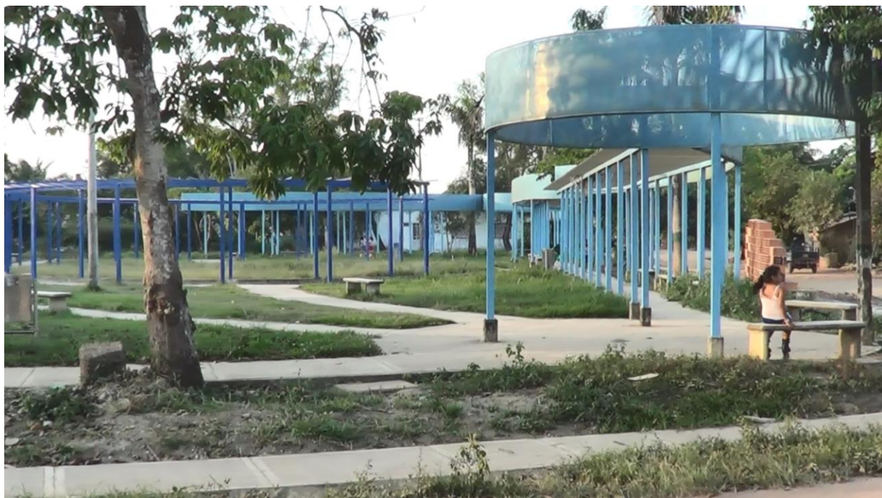
Ilustración 3. Imágenes de la obra recibida
