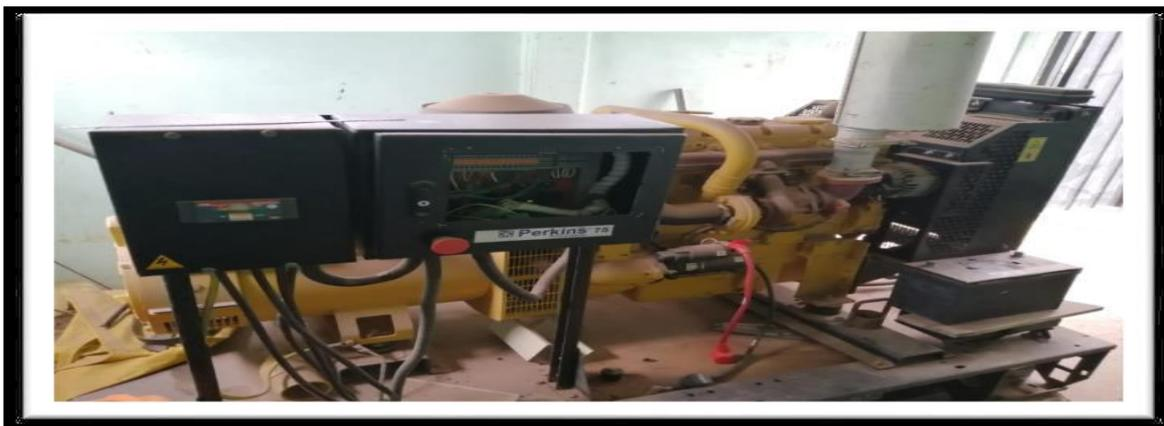
**Estación Coopsagua:** Esta estación que opera el sistema de alcantarillado de Barrios de oriente presenta inconvenientes de operación y funcionamiento de los equipos de bombeo, sistema de isage, equipos de control electrónico, tablero de control y sensores.
